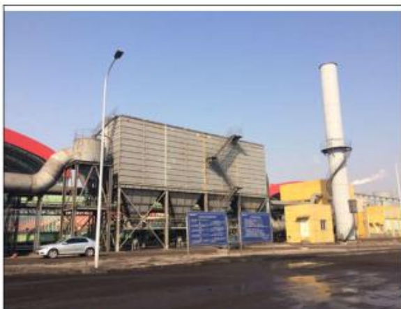
汽车卸料及 S4 S5 转运站除尘设施
