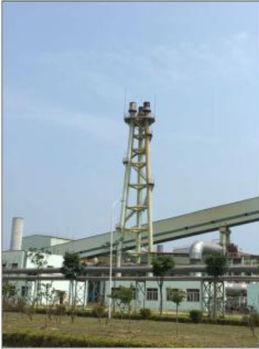
高炉煤气放散塔
